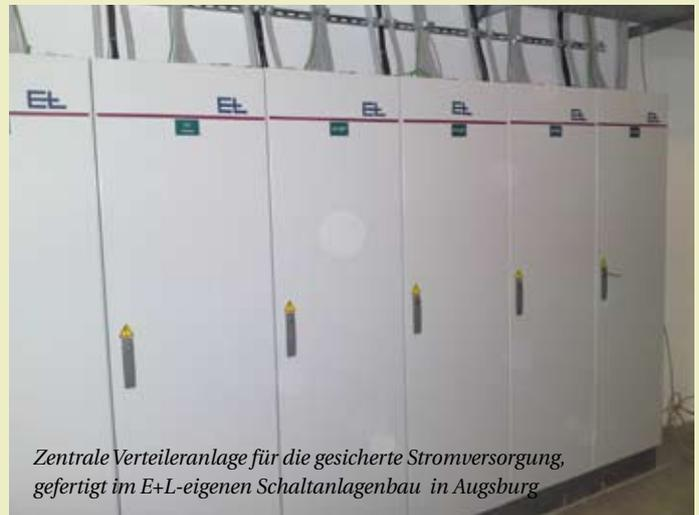
*Zentrale Verteileranlage für die gesicherte Stromversorgung, gefertigt im E+L-eigenen Schaltanlagenbau in Augsburg*
