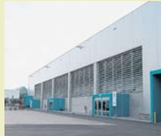
Heizen und kühlen mit Grundwasser in der Messehalle 5
